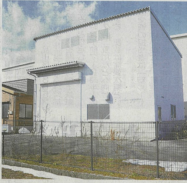
イノシシ解体処理施設に改装するバイオエタノール実証実験施設
